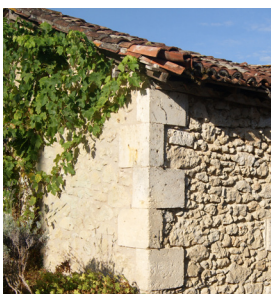
Pierre de taille, au chaînage des angles et mur en moellons.
