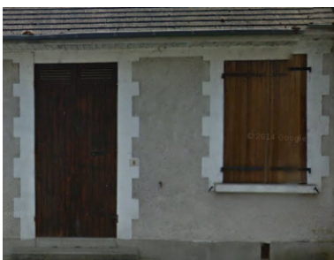
Pierres de taille, réservées aux entourages des ouvertures.
