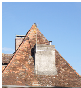
Toiture traditionnelle en tuiles plates.
