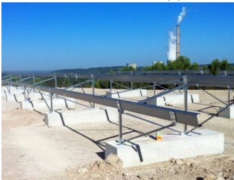
Exemple de longrines en béton Site URBASOLAR de Gardanne (13)
