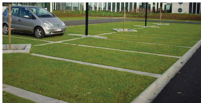
Fig. 5. Principe de stationnement mutualisé enherbé.
